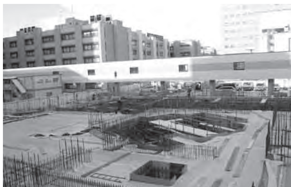
図5 建屋建設状況 (2011年11月北海道大学病院敷地内)
